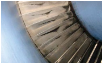
Contaminación por Fouling
